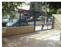
Entrada do prédio
